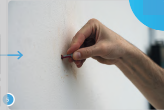
5 ...und stecke dann die Wanddübel hinein.
