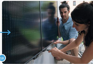
18 ...und ziehe die Schrauben bei Bedarf etwas nach.
