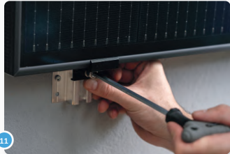
11 Wenn sich die Klemme in der endgültigen Position befindet, kannst du sie mithilfe der Schrauben und eines Drehmomentschlüssels fixieren.
