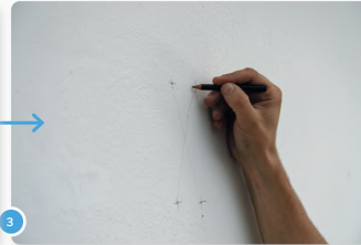
3 Überlege dir, wo du die Profile anbringen wirst, damit diese parallel zueinander an die Wand geschraubt werden können.
