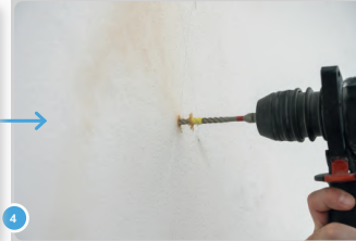
4 Bohre nun mit einem passenden Bohrer an den vorgesehenen Stellen Löcher...
