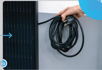
20 Führe das Kabel hinter den Panelen hindurch...
