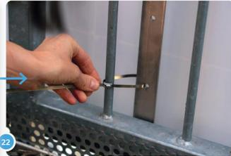
Jetzt kannst du die Kabelbinder um das untere Ende der Balkonhaken führen. Zurre sie so fest, dass das Panel nicht mehr schwingen kann.
