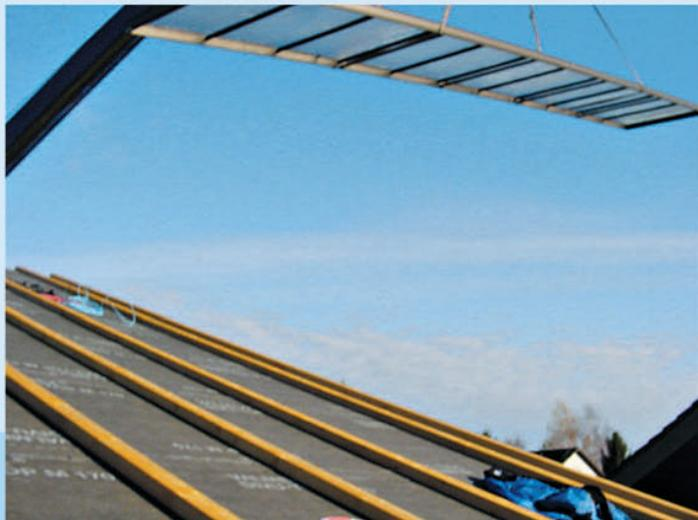
Auch große Solarmodule für Solardachlösungen werden von uns fachgerecht montiert. Auf diesem Bild erstreckt sich das Solarmodul von der Traufe bis zum First. Die Montage umfasst auch die Einblechung der Module auf dem Dach.
