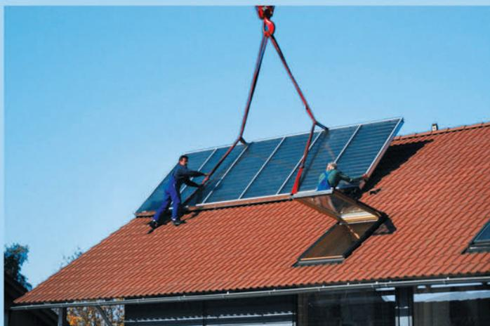
Einzelne Kollektoren werden von 2 Monteuren in ca. 1-2 Stunden montiert.
